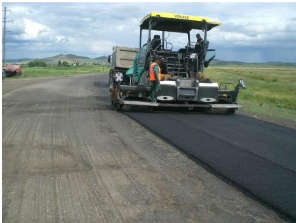
Ремонтные работы на автомобильной дороге регионального значения, 2025 г.
