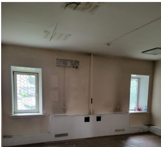
Фото до начала ремонтных работ, июль 2025 год
